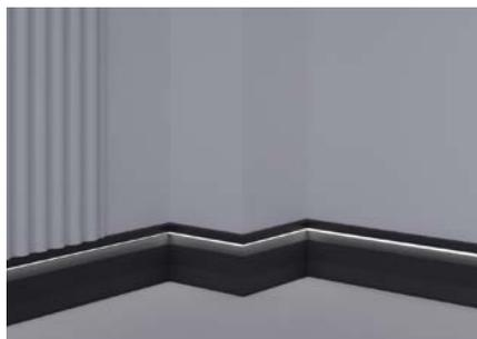
Os rodapés abrangem cantos em 90°, tanto internos quanto externos. Basta cortar os perfis em 45° e encaixar nos suportes da mesma maneira.
